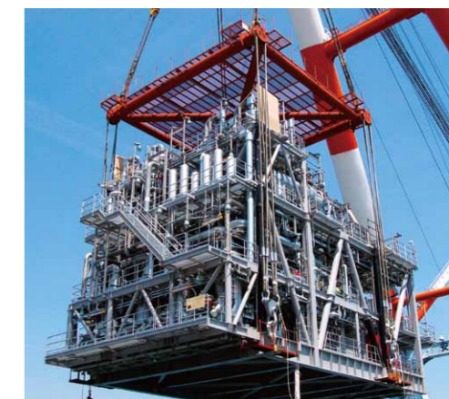
ガスコンプレッションモジュール 洋上プラットフォーム向け(工場出荷風景)
