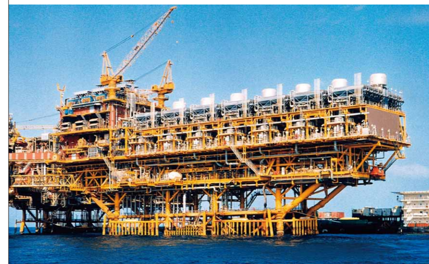
ガスコンプレッションモジュール 洋上プラットフォーム向け(インド)
