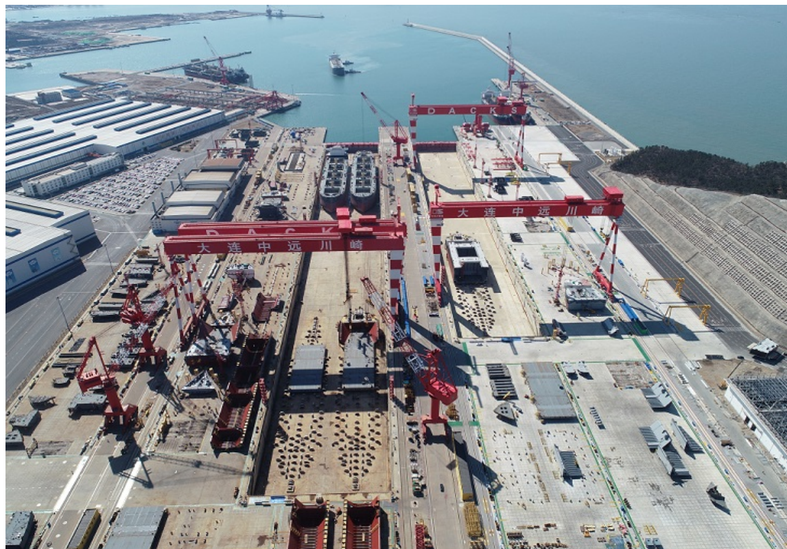
DACKS工場全景。右側のドックが第二ドック
