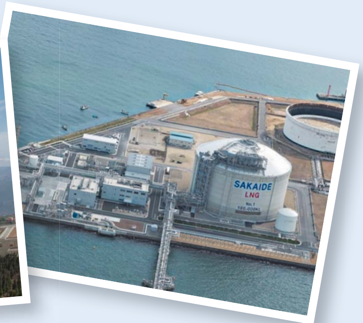
Sakaide LNG Terminal
