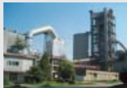
中国向けセメント排熱発電設備
