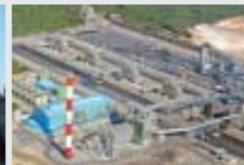
ブラジル向けコークスガス回収発電設備
