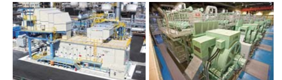
(株)ダイセル向けL30AガスタービンパッケージPUC300D 日本テクノ(株)袖ヶ浦グリーンパワー向けガスエンジン発電設備
