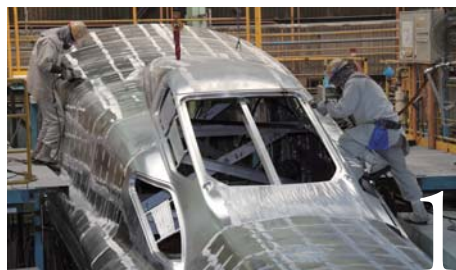
先頭車両の構体組立
